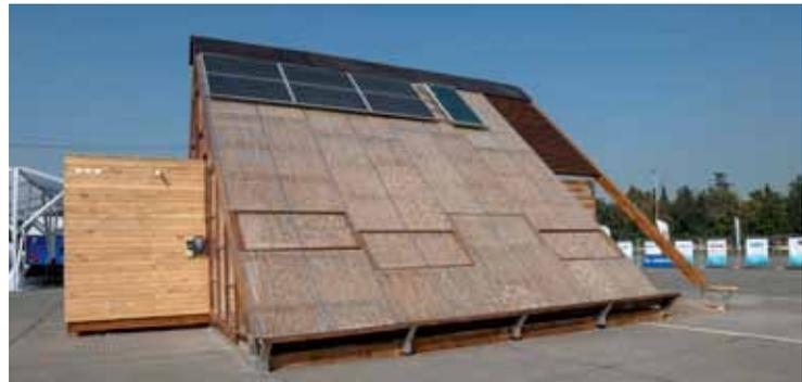
Además, cuenta con materiales de polibambú DVP, planchas de policarbonato con bambú integrado, de apariencia natural, con filtro UV, que ayuda a reducir la intensidad de los rayos solares y el sobre calentamiento de la vivienda.
