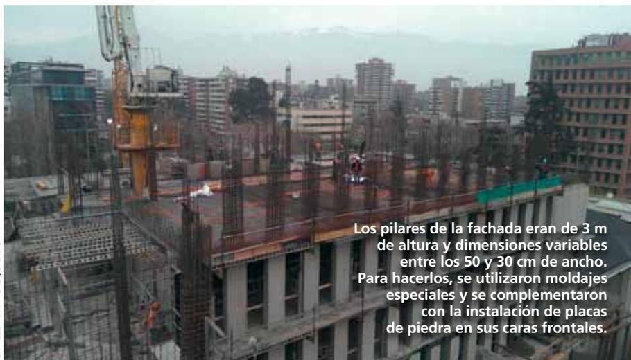
Los pilares de la fachada eran de 3 m de altura y dimensiones variables entre los 50 y 30 cm de ancho. Para hacerlos, se utilizaron moldajes especiales y se complementaron con la instalación de placas de piedra en sus caras frontales.
