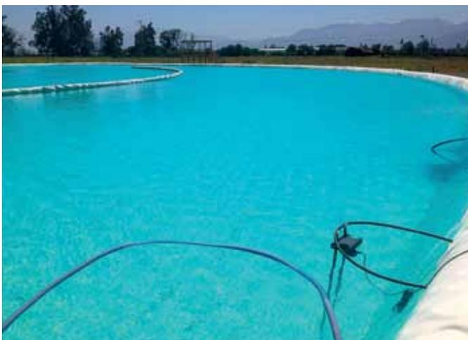
En diciembre de 2013 finalizó la construcción de la laguna de enfriamiento piloto de 5.000 m<sup>2</sup> en la central termoeléctrica San Isidro, de Endesa. Esta laguna tiene el propósito de verificar la factibilidad de aplicar esta tecnología para mejorar la eficiencia del proceso de refrigeración de este tipo de centrales.
