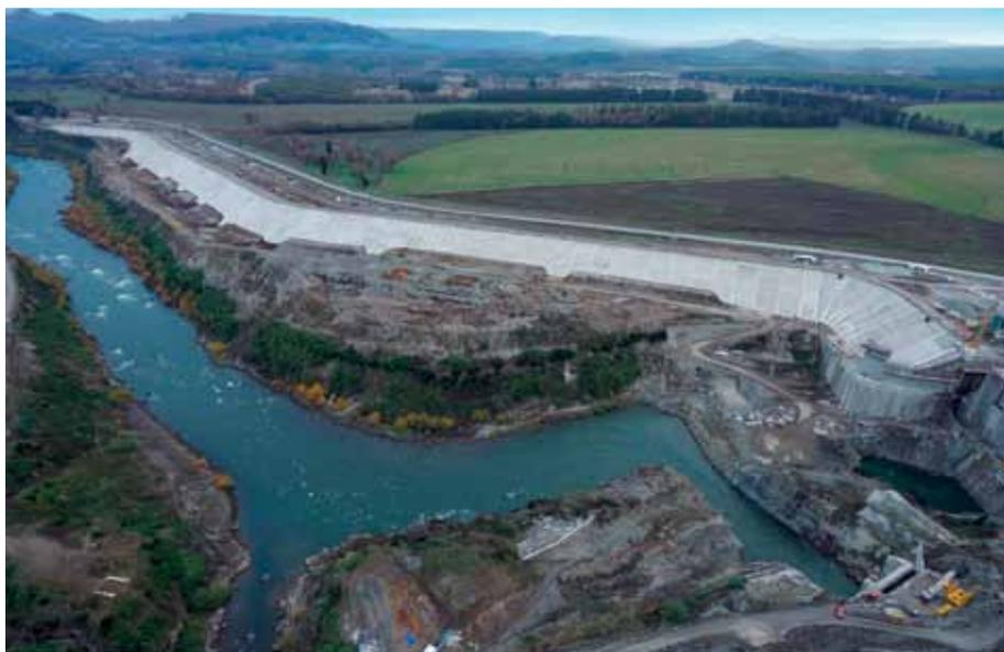
El pretil tiene una longitud de 1.600 m, altura máxima de 32 m, un volumen de 1.600.000 m<sup>3</sup> de material de relleno y 100.000 m<sup>3</sup> de hormigón convencional en su cara mojada.
