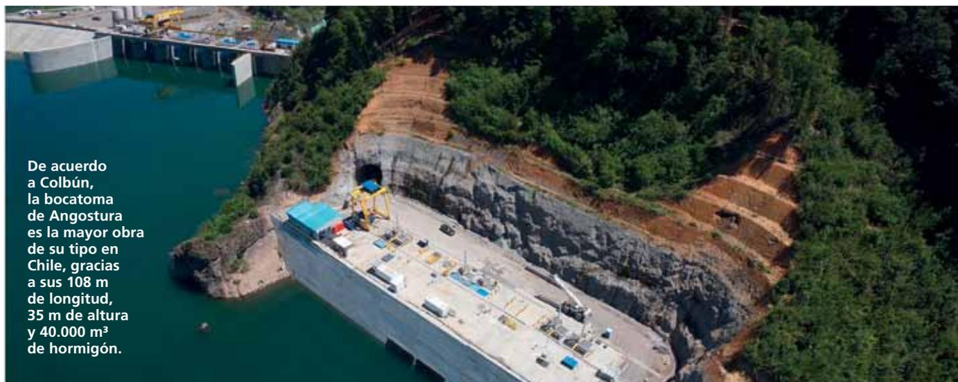
De acuerdo a Colbún, la bocatoma de Angostura es la mayor obra de su tipo en Chile, gracias a sus 108 m de longitud, 35 m de altura y 40.000 m<sup>3</sup> de hormigón.
