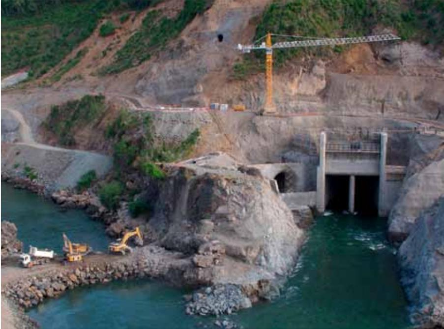
Utilizado para desviar el río y construir la presa sobre el lecho seco, el túnel de desvío tiene una longitud de 300 m y un diámetro de 15 metros.
