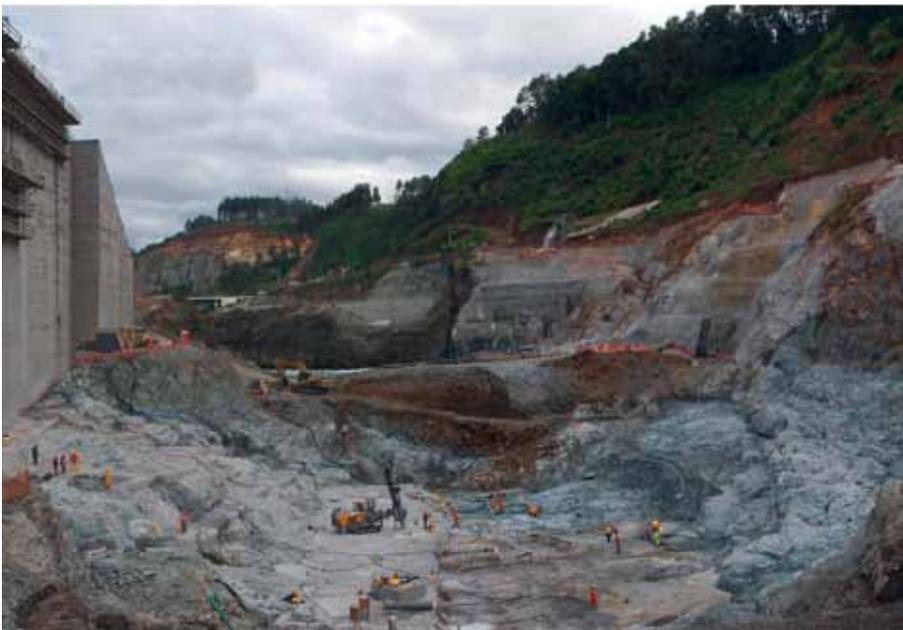
La presa tiene 60 m de altura y 130 m de longitud. Su cuerpo está constituido por 300.000 m<sup>3</sup> de hormigón compactado con rodillo (HCR), siendo ejecutado entre febrero y septiembre del 2012.
