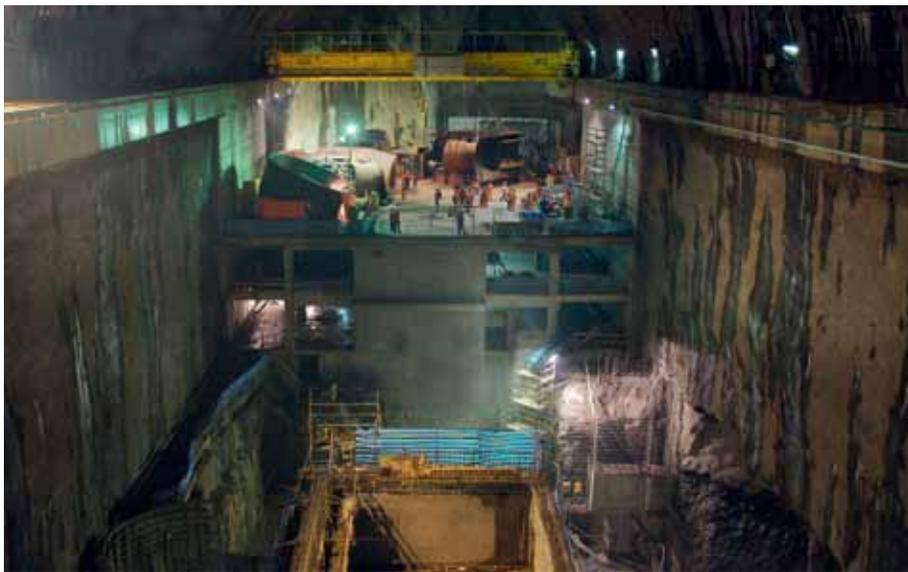
La caverna tiene 43.000 m<sup>3</sup> de hormigón convencional, distribuidos en cuatro niveles: drenaje, tuberías, generadores y nivel principal.
