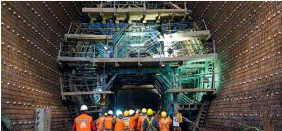
rollo paralelo entre sí, con longitudes de 366 m, 307 m, y 246 m. Son revestidos en hormigón armado y en el sector de llegada a la caverna poseen 20 m de blindaje de acero”, detalla.
