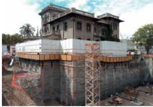
Uno de los métodos constructivos más utilizados para realizar excavaciones para espacios subterráneos, son las pilas de socalzado que sirven para sostener el terreno bajo el cual se quiere construir. En la imagen, se aprecia la excavación para estacionamientos cerca del palacio Falabella en Providencia.
