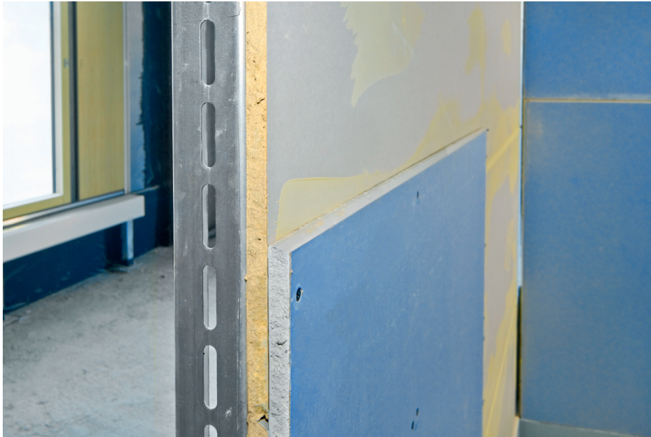
Figura 1.12. Tabique interior que proporciona protección antirradiación.
