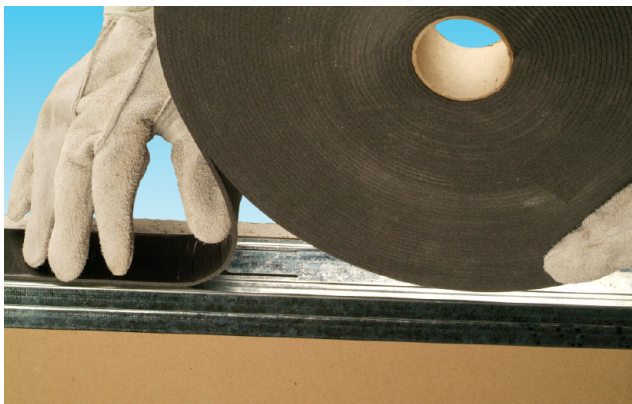
Figura 5.4. Ejemplo de instalación de banda acústica para sello perimetral.
