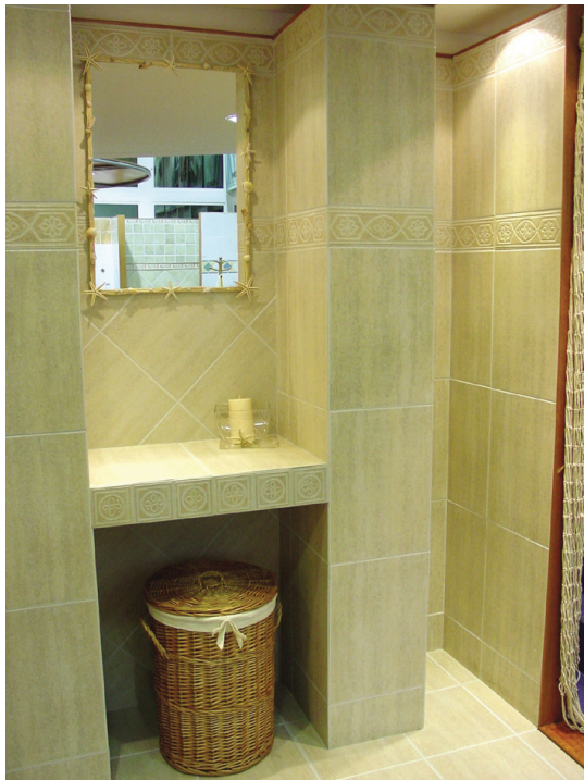
Figura 5.6. Correcta instalación de cerámica en recinto húmedo.
