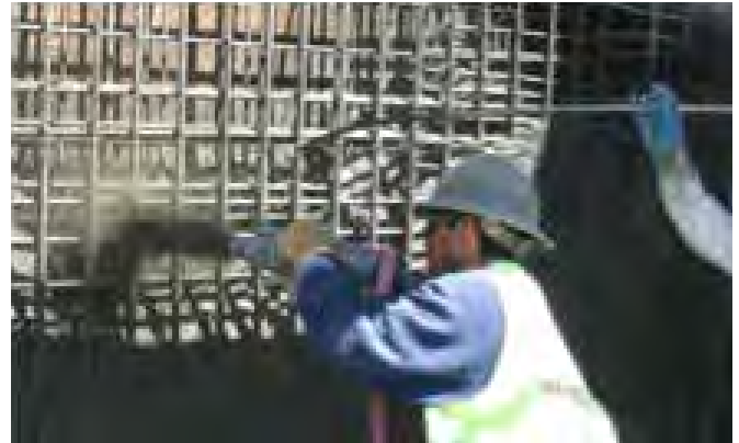
Figura 2.2 Shotcrete a través de varias secciones de armaduras en muro.
