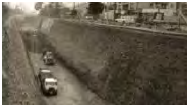
Figura 1.19 Tramo Línea 1 Metro de Santiago, sección Evaristo Lillo, Metro Estación Escuela Militar, Las Condes, (1970-80).
