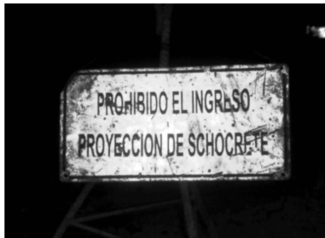
Figura 13.5 Señalética anunciando la operación de shotcrete.
