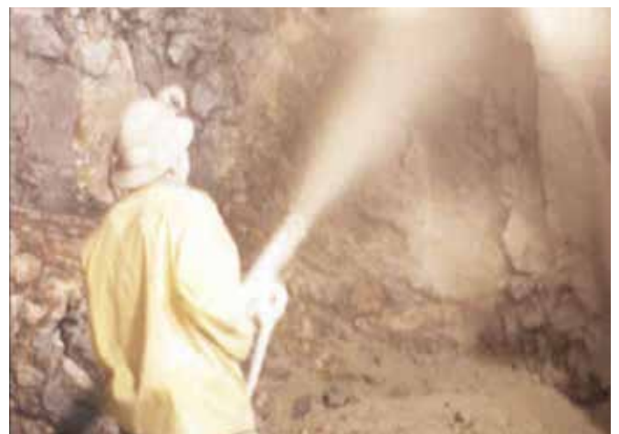
Figura 1.3 Shotcrete sobre roca.
