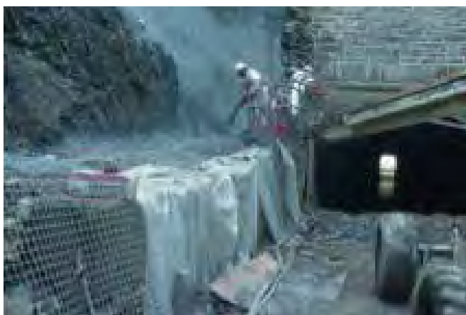
Figura 1.10 Estabilización de talud.
