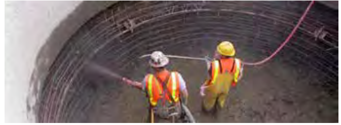
Figura 4.5 Aplicación de shotcrete sobre malla.
