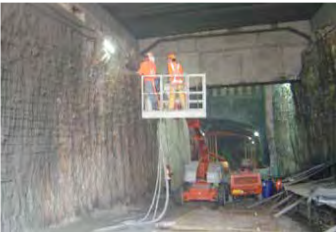
Figura 9.19c Detalle de aplicación de shotcrete manual sobre equipos de levante, en obra subterránea.
