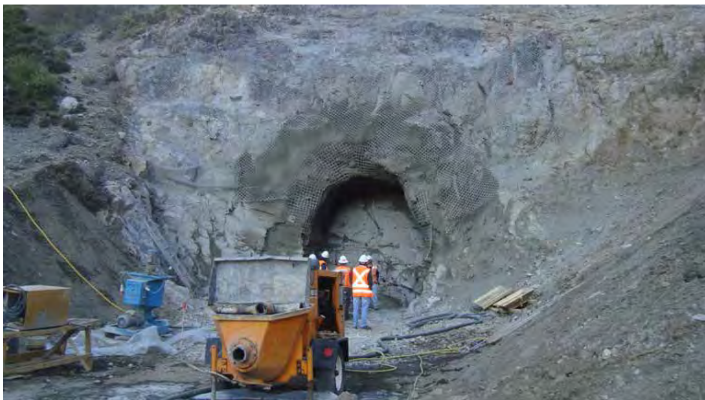
Figura 8.4 Bomba dispuesta para faena de shotcrete.
