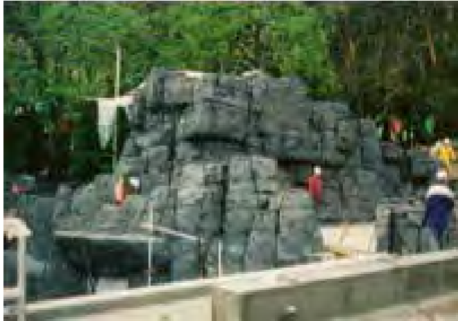
Figura 1.12 Acabados decorativos con shotcrete.
