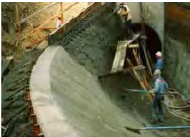
Figura 1.9 Hormigón proyectado en un canal hidráulico.
