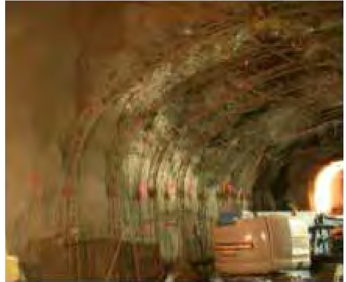
Figura 2.3 Shotcrete a través de secciones de marcos reticulados estructurales.
