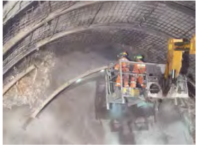
Figura 4.6 Instalación de malla en túnel.
