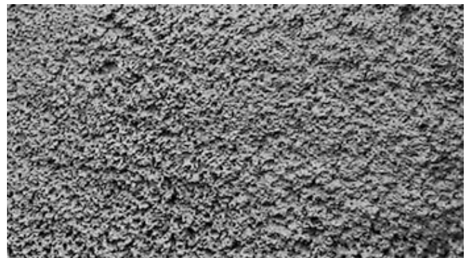
Figura 9.13 El acabado "de boquilla" puede ser adecuado para muchas aplicaciones.
