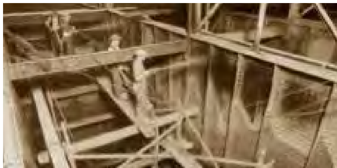
Figura 1.16 Faena de proyección de Shotcrete cercano a 1930
