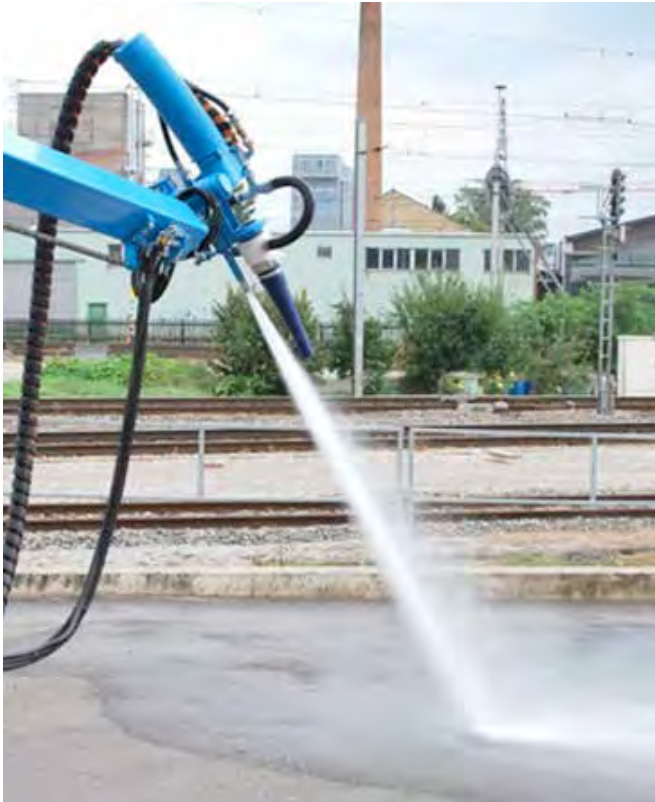
Figura 9.25b. Scaling con agua, o hydroscaling, la figura presenta un accesorio adicional al brazo que aumenta la presión de la salida de agua para una mejor limpieza.
