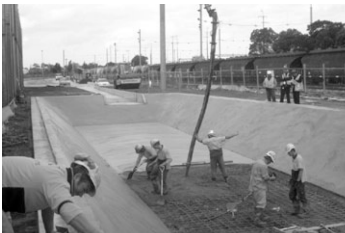
Figura 9.19 Construcción de canal con hormigón proyectado.
