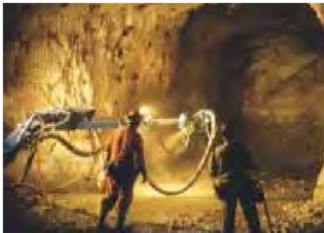
Figura 1.4 Shotcrete en Túnel.
