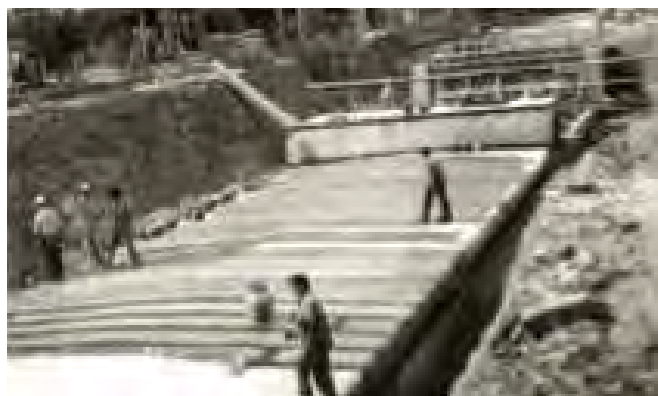
Figura 1.18 Tramo línea 1 Metro de Santiago, cubierta sector Holanda, Providencia (1970-80).
