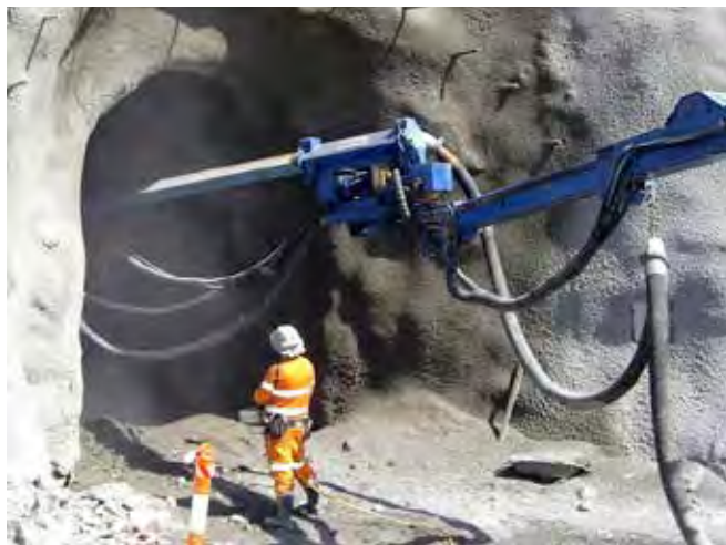
Figura 6.9 Operador con control a distancia de la proyección.
