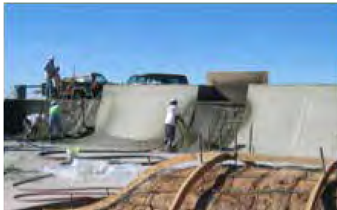
Figura 1.11 Skateparks con hormigón proyectado.
