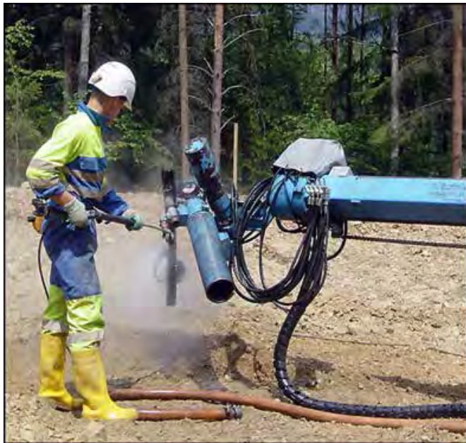
Figura 9.29 Limpieza del equipo de shotcrete.
