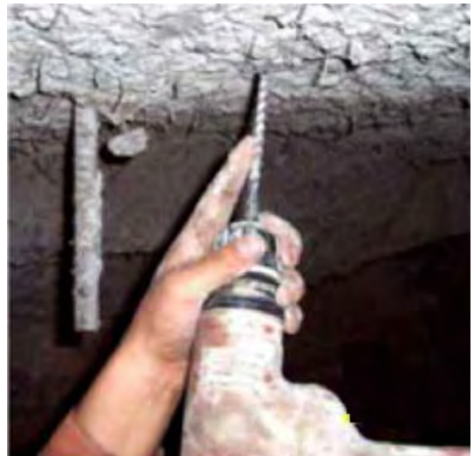
Figura 9.28b Control de espesor por perforación.
