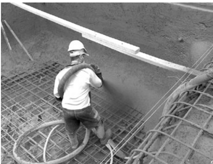
Figura 9.18 Construcción de una piscina con hormigón proyectado.
