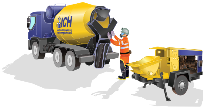
Figura 13.10 En la recepción del hormigón por parte del operador se debe tener en cuenta que debe estar visible durante las labores de retroceso del equipo, hasta su completa detención y nunca ubicarse entre el capacho y el equipo de transporte.
