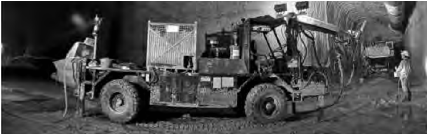
Figura 6.11 Equipo de proyección usado en obras de minería subterránea y obras civiles e infraestructura.
