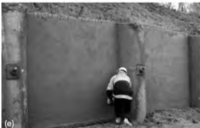
Figura 9.17 Proceso de proyección en muro de contención con shotcrete manual.
