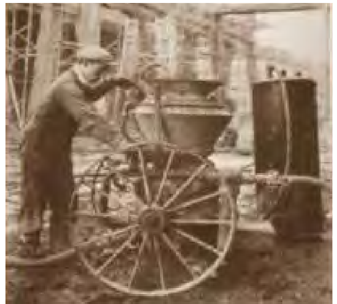
Figura 1.15b Equipo de shotcrete de 1920.
