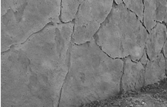
Figura 9.15 Terminación de muro imitación de roca.
