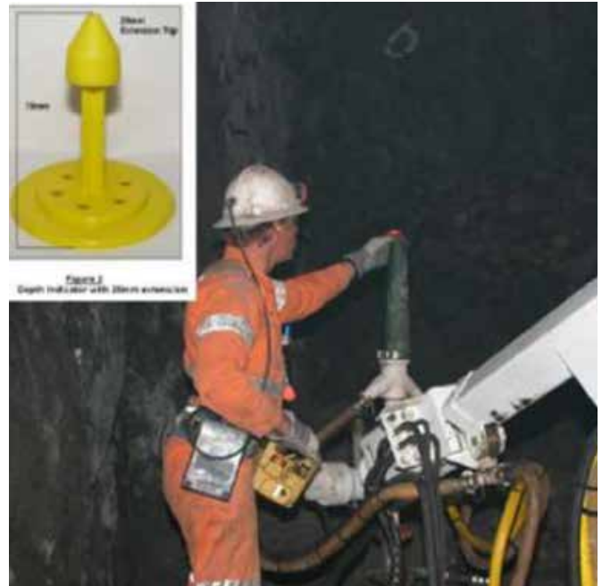
Figura 9.28a Control de espesor. Puntas adheridas al sustrato.
