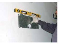
Primero se comienza en la selección de un lugar para ubicar la unidad interior. Para esto, se utiliza una placa de montaje que se monta sobre una superficie plana del muro.
