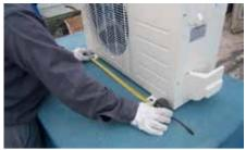
La unidad exterior se instala en una base rígida para impedir el desnivel, la generación de ruido y la vibración, determinando la dirección de la salida de aire de modo que no sea bloqueada.
