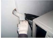
Entre las dos unidades se deben montar líneas de cañerías para refrigerante compuestas por dos tubos de cobre y unas mangueras eléctricas que unen los dos equipos.
