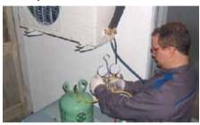
Una vez hermético, se procede a conectar un manómetro y una bomba para realizar un vaciado de humedad a la unidad interior y a la tubería de interconexión.
