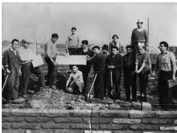
FIGURA 1. AUTOCONSTRUCCIÓN POR AYUDA MUTUA. COMITÉ CAMPANA SUR, VILLA LA REINA
