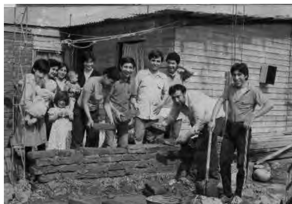
FIGURA 2. AUTOCONSTRUCCIÓN. VILLA 12 DE OCTUBRE, SAN MIGUEL
