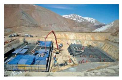
beta cilíndrica, con valores de trabajabilidad comprendidos entre 10 y 18 cm de asentamiento de cono de Abrams.
