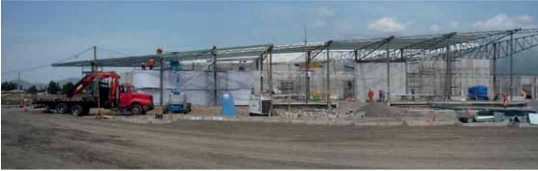
**Sobre los pilares se instalaron nueve vigas metálicas, de diferentes dimensiones, prefabricadas. Entre estas cerchas, apoyadas en los pilares, se apernaron las vigas y "costaneras".**
