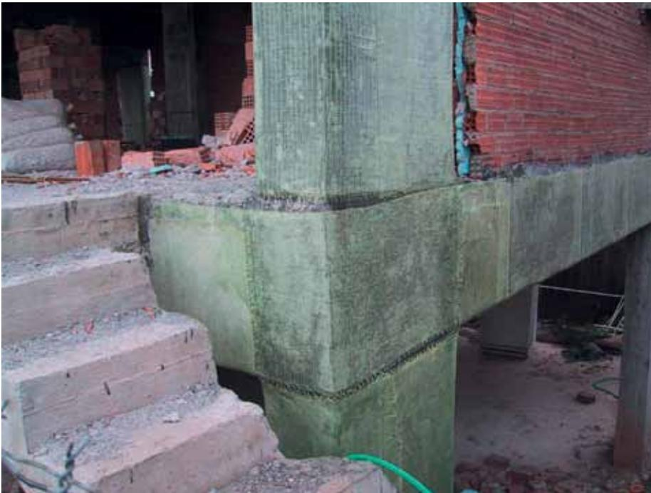
Refuerzo de fibra de carbono para el corte y flexión de vigas.
