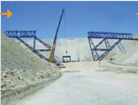
**3. Una vez que la estructura queda estable, se procede a levantar la galería central.**
