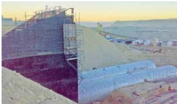
Lado sur del Stock Pile en trabajo de fundaciones y túneles.
