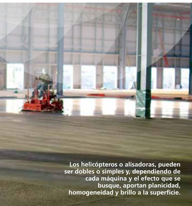
Los helicópteros o alisadoras, pueden ser dobles o simples y, dependiendo de cada máquina y el efecto que se busque, aportan planicidad, homogeneidad y brillo a la superficie.
