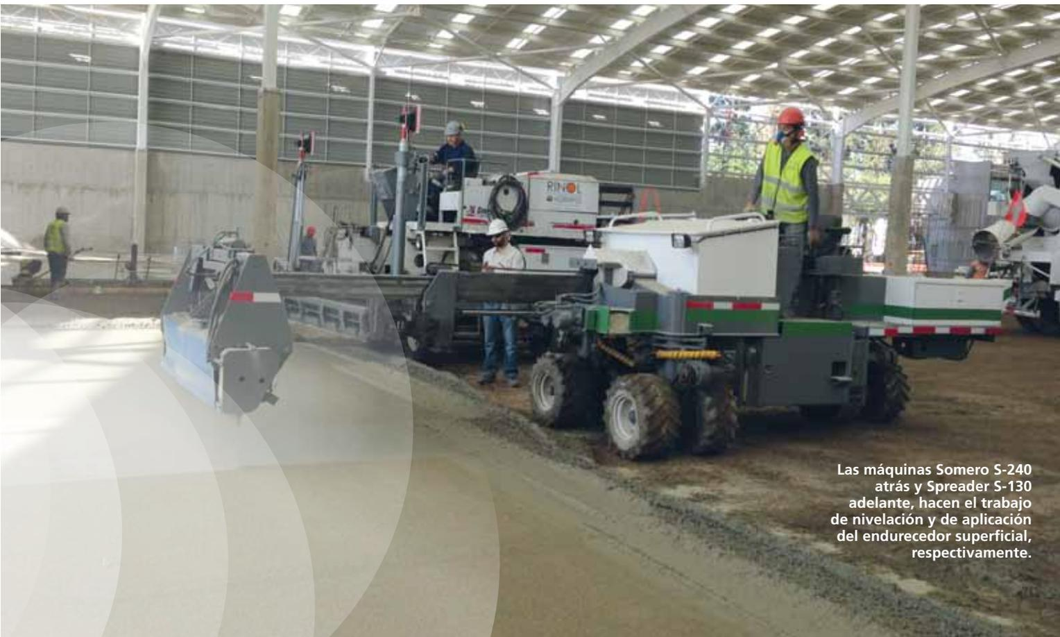
Las máquinas Somero S-240 atrás y Spreader S-130 adelante, hacen el trabajo de nivelación y de aplicación del endurecedor superficial, respectivamente.
