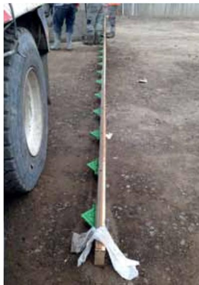
Instalación de una junta Diamond Dowel.
