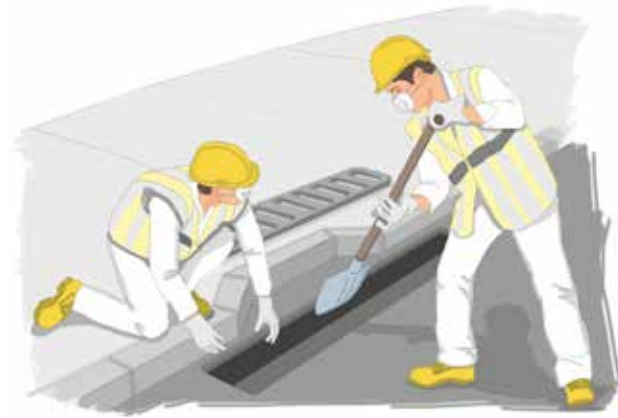
SUMIDEROS AGUAS LLUVIAS
