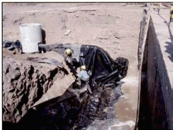
Fig. 9.1.- Instalación de membranas impermeables en ductos de agua (Olguín, 2006).
