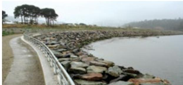
Fotografías: rompeolas y muro de contención de la costanera
