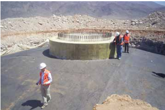
La estructura circular que sobresale de la fundación queda sobre la superficie y en ella se aprecia los 200 pernos de anclaje sobre los que se montará la torre de acero.
