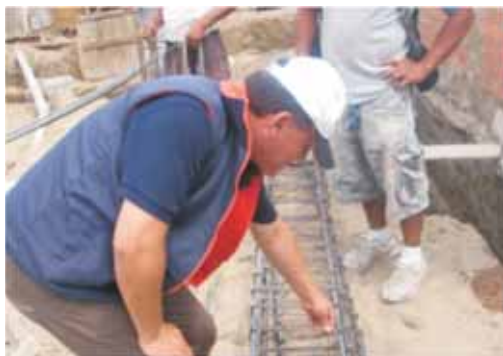
Asistencia Técnica en Construcción, Perú
