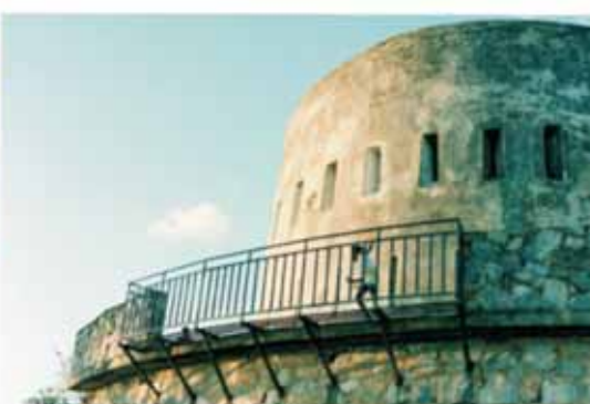
Restauración Fort Picton
