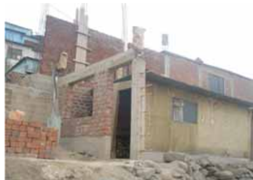
Construcción progresiva de vivienda, Perú
