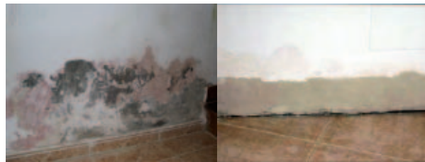
Figura 1.2. Humedad por capilaridad.
