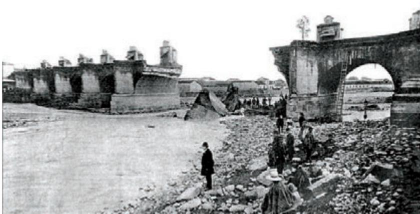
Figura N° 12. El puente Cal y Canto poco después de sufrir el derrumbe de algunos de sus arcos, en agosto de 1888. Se ven los baratillos instalados en la superficie de la estructura. Se advierte, además, la presencia de espectadores de chaqueta y sombrero junto con otros –en primer plano– de poncho y chupalla, contemplando lo que para entonces se había convertido en un espectáculo urbano. Archivo Fotográfico Museo Histórico Nacional.
