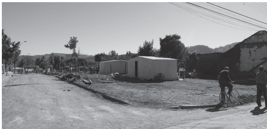
▲ La situación de Curepto luego de retirados los escombros. Fuente fotografía Equipo UC, Mayo 2010
