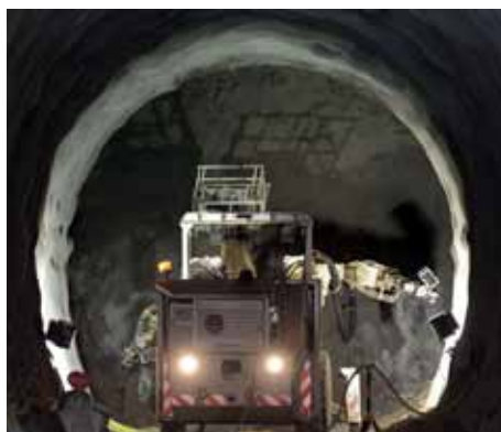
CONSTRUCCION TUNEL DE ACCESO NUEVO NIVEL MINA - CODELCO DIVISION TENIENTE CONSTRUCTORA DE TUNELES MINEROS
