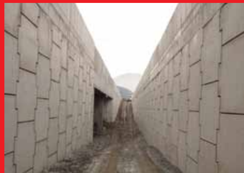
MURO ACCESO ESTACIONAMIENTOS PROYECTO PARQUE TITANIUM
