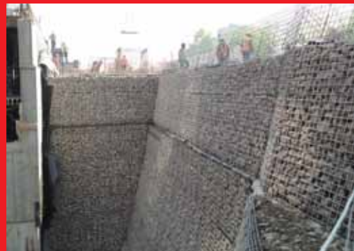
MURO DE CONTENCIÓN TEMPORAL PROYECTO PARQUE TITANIUM
