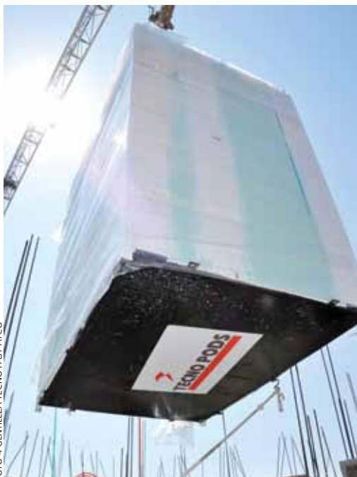
FOTO 4 GENTILEZZA TECNICO FAST ATCO
