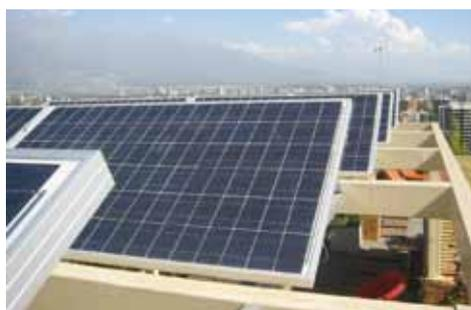
▸ Ubicado en el último piso de un edificio de Providencia, el sistema solar fotovoltaico consistente en 10 paneles, logra cubrir el 80% de la demanda de electricidad del arquitecto, al producir 1.630 kWh anuales.
