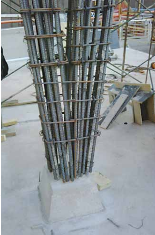
Armado de las diagonales antes de ser hormigonadas.
