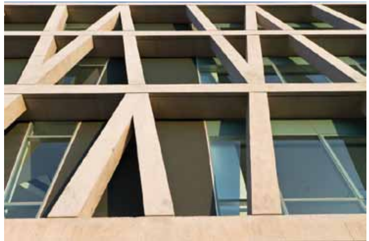
Las diagonales tienen dos funciones. Por un lado entregan resistencia dinámica, que aporta flexibilidad ante eventos sísmicos, protegiendo elementos secundarios y por el otro, aportan resistencia estática que permite descargar el esfuerzo del peso propio de la obra hacia el suelo.
