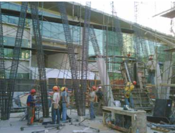
Armado de las diagonales antes de ser hormigonadas.
