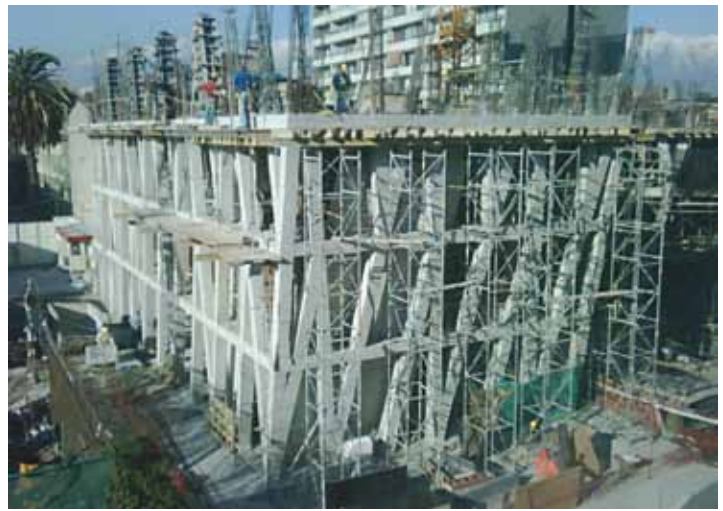
Para la construcción del 'exoesqueleto' se utilizaron moldajes de 35 x 35 cm, hechos de manera artesanal ya que los pilares de la estructura presentaban hasta cuatro ángulos de inclinación diferentes.
