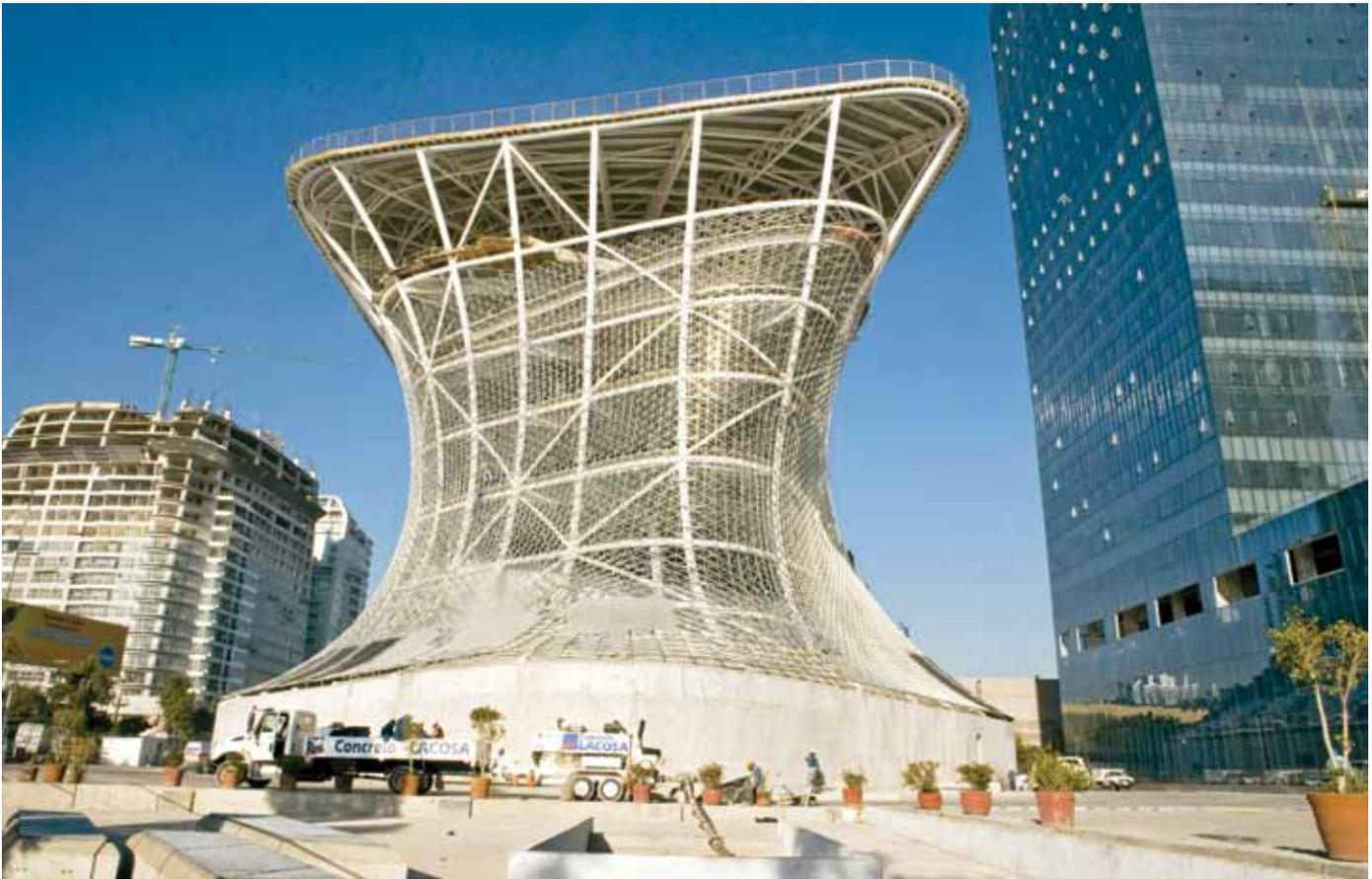
**La estructura comprende 28 columnas tubulares curvas, cruzadas por 7 anillos de acero por cada nivel.**
