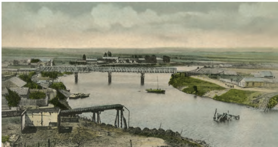
Nueva Imperial. Puente carretero y restos del puente del ferrocarril hundido. Colección Museo Histórico de Chile. 1920.
