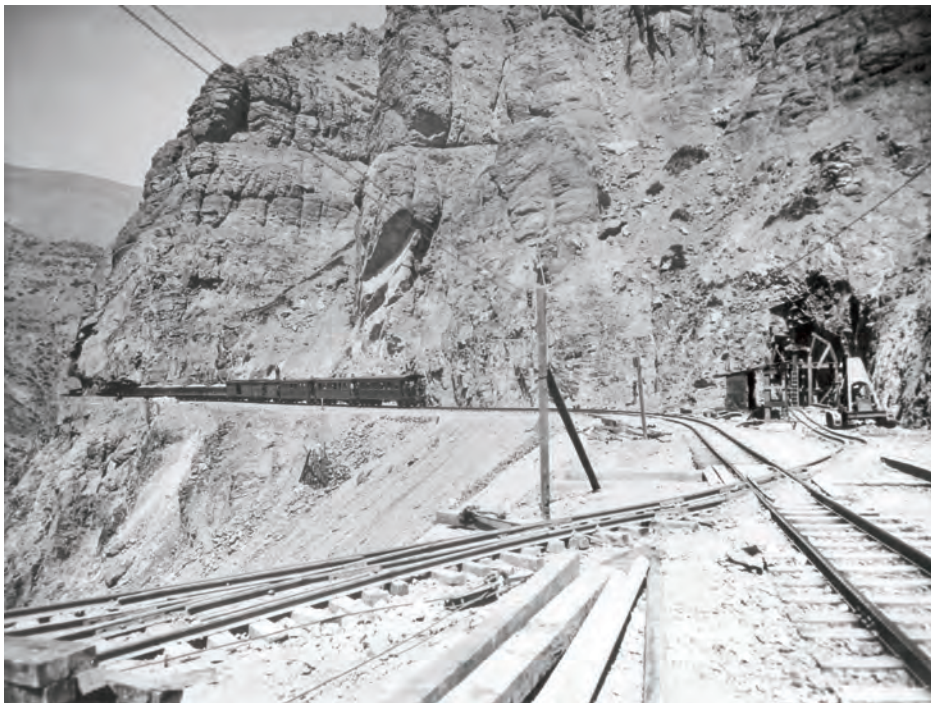
Trabajos de apertura del túnel Copado del ferrocarril de El Teniente. Colección Carlos Roa.
