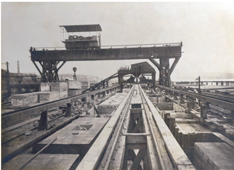
Cancha para la fabricación de bloques de concreto en Las Salinas, mostrando la grúa Goliath de sesenta toneladas. Colección Archivo Fotográfico y Digital. Biblioteca Nacional de Chile.
