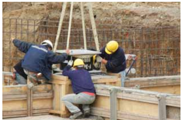
Figura 42. Instalación de aislador sísmico. UNIVERSIDAD CATOLICA DEL MAULE (CHILE)
