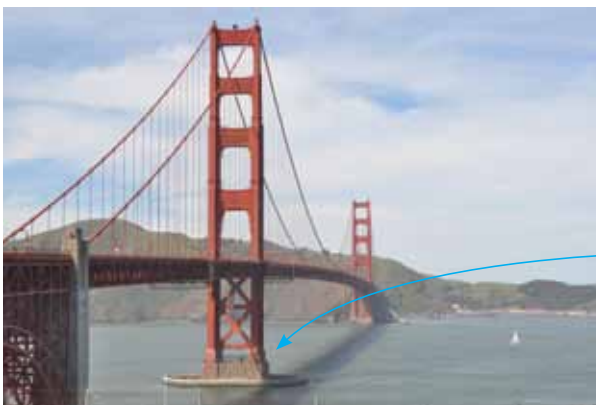
Figura 38. Estructura reforzada. PUENTE GOLDEN GATE, SAN FRANCISCO (EEUU)
