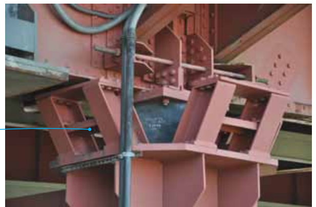
Figura 39. Aislador elástico. PUENTE GOLDEN GATE (EEUU)
