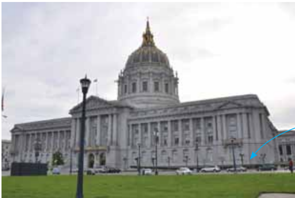
Figura 36. Estructura reforzada. SAN FRANCISCO CITY HALL (EEUU)
