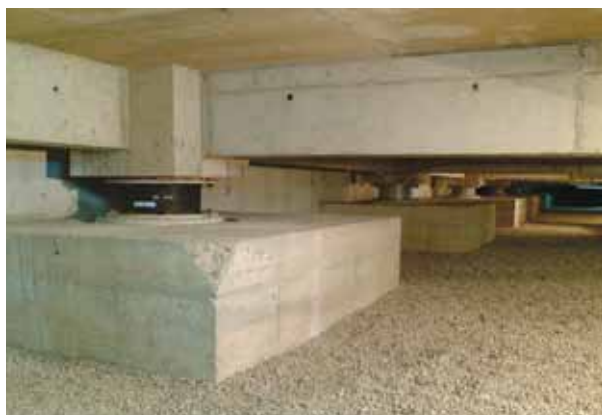
Figura 32. Aplicación aislador elastomérico. EDIFICIO SAN AGUSTÍN (CHILE)
