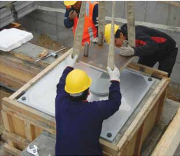
Figura 28. Apoyo deslizante plano. UNIVERSIDAD CATÓLICA DEL MAULE (CHILE)
