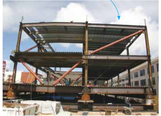
Figura 35. Aplicación de apoyos elástico en techo de edificio. BERRY STREET (EEUU)
