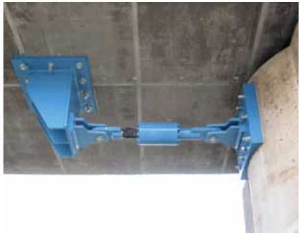
Figura 23. Aplicación amortiguador viscoso en apoyo de puente.
