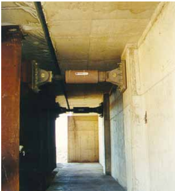
Figura 24. Aplicación amortiguador viscoso. PUENTE AMOLANAS (CHILE)
