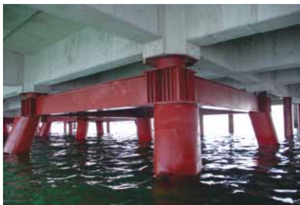
Figura 33. Aplicación aislador elastomérico. MUELLE CORONEL (CHILE)
