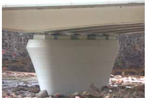
Figura 40. Puente con aisladores sísmicos.
