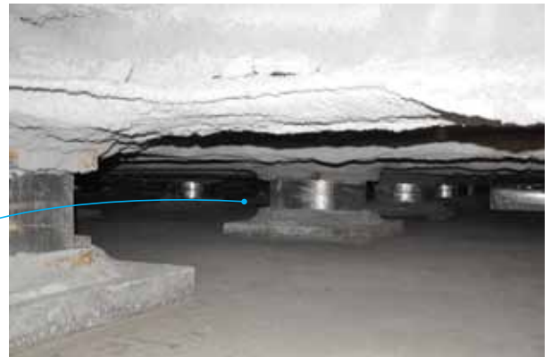
Figura 37. Aisladores elásticos. SAN FRANCISCO CITY HALL (EEUU)
