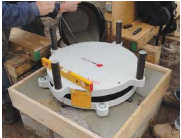
Figura 41. Proceso de instalación de péndulo friccional. DATA CENTER SONDA (CHILE)
