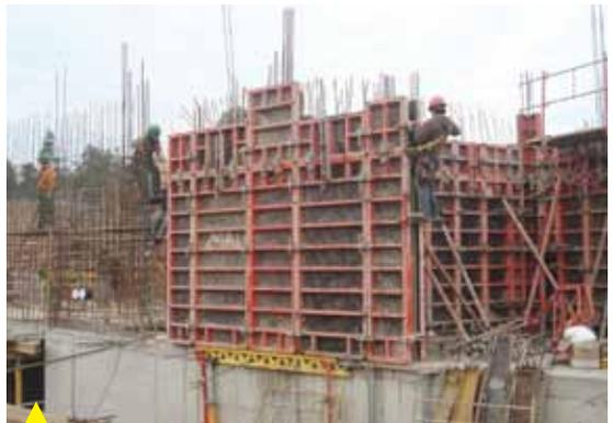
Se utilizó un moldaje en base a paneles uniformes definidos por la arquitectura en módulos de 60x120 centímetros. En total, para la construcción de este complejo se utilizaron 74.290 m<sup>2</sup> de moldaje.
