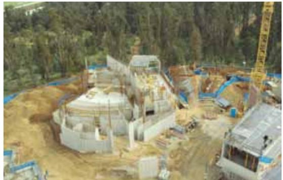
“El principal desafío fue entender la geometría que deseaban los arquitectos, con volúmenes interiores y exteriores a distintos niveles, teniendo que levantar estructuras de moldaje de varios pisos para hormigonar las losas de cielos, las cuales tampoco se encuentran a un mismo nivel”, indica Ríos.
