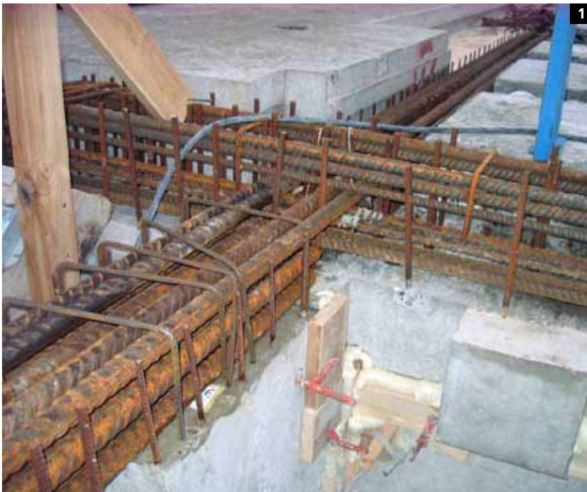
1. Refuerzo en la articulación de la planta por encima del muro transversal y longitudinal de la pared. 2. Modelo 3D de la enfierradura. 3. Refuerzo en las fundaciones de la torre 1.
