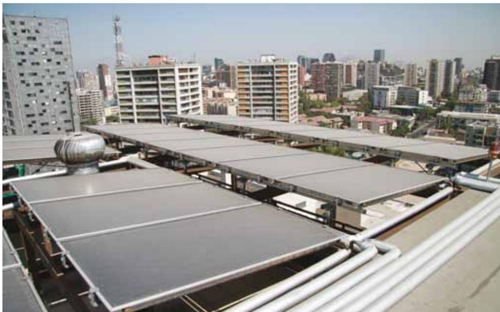
**Gracias a los 75 paneles solares con capacidad de 7.500 litros de acumulación, instalados en el edificio Santiago Oriente, los ahorros de la comunidad alcanzan actualmente un 65%, de acuerdo a las mediciones realizadas por el software WRS de la empresa alemana Wolf.**
