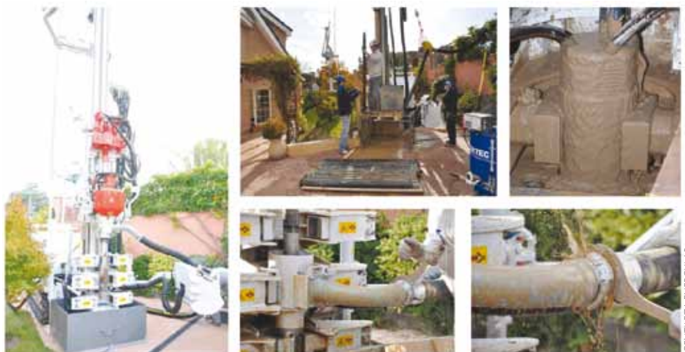
Instalación de bombas de calor en España.
