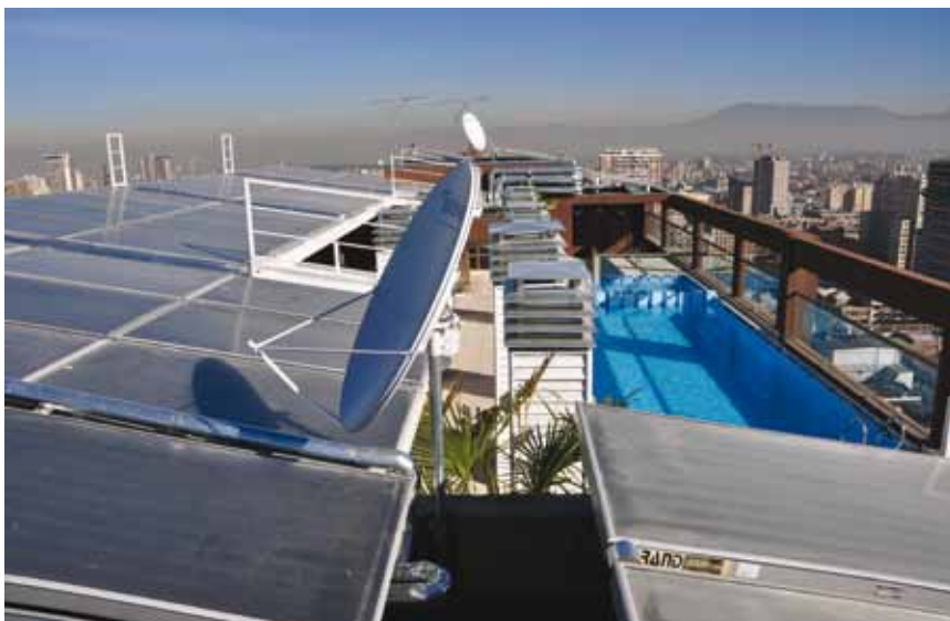
El proyecto de paneles solares más grande del país se instaló en el edificio Alto Serrano de Santiago.
