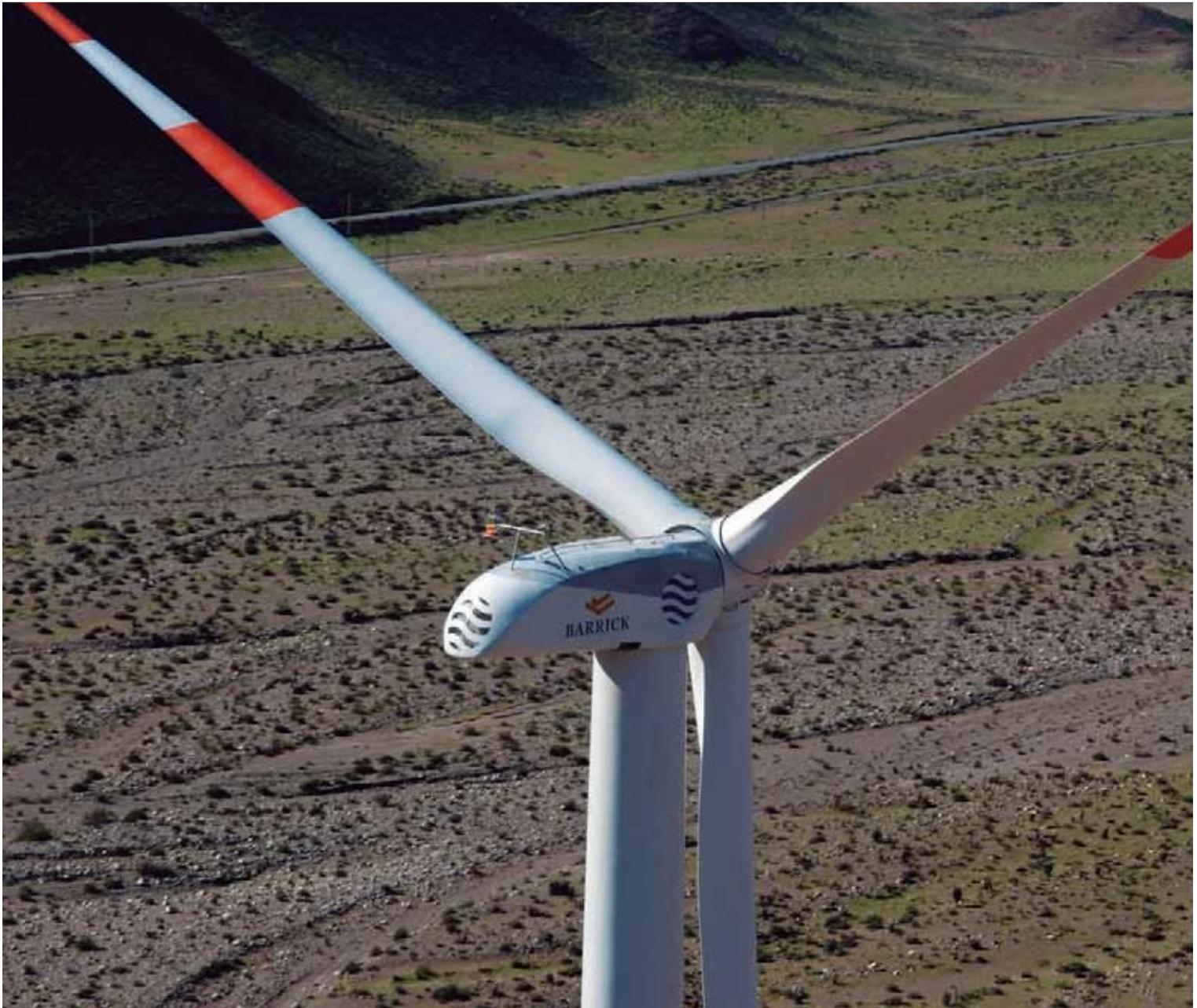
Cada aerogenerador pesa más de 300 toneladas y tiene capacidad para generar 2 MW.
