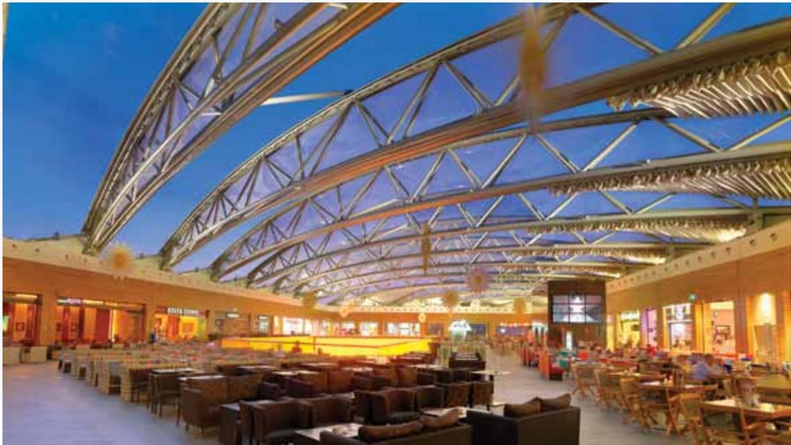
▶ Dado a que los hilos de fibra de vidrio se quiebran al plegarlos, el equipo de formTL desarrolló un proceso de doblado que evita el pliegue de los hilos. Para ello, ambos lados de la membrana tienen las mismas distancias. Situación que se logró haciendo que la cuerda inferior de las cerchas se desarrolle como una “spline” en 3D. La técnica de deslizamiento de la membrana y los posibles problemas que pudieran aparecer se probaron en un modelo escala 1:1.
