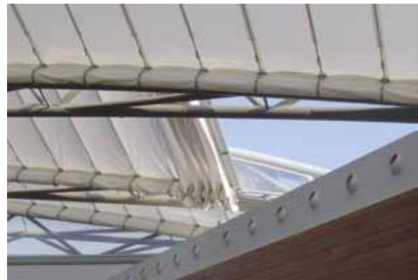
Las membranas de silicona-fibra de vidrio, orientadas hacia el sur, van fijadas a rieles de aluminio por los cuales pueden deslizarse a través de las cuerdas de las cerchas. Estas pueden ser tiradas por cables manejados con motores para abrir o cerrar la cubierta.
