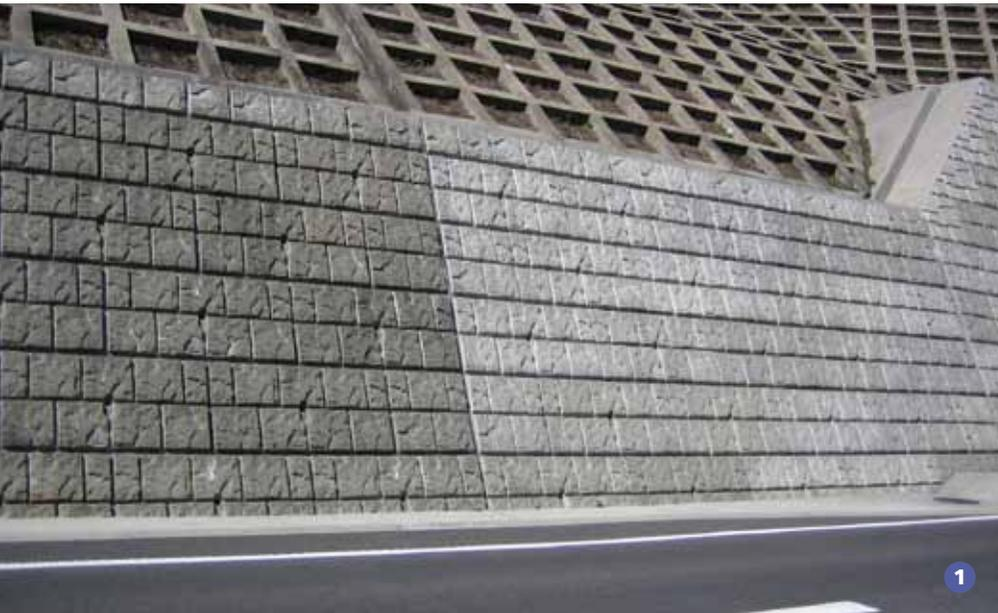
1. Producto outdoors. Uso de fotocatalisis heterogénea en hormigón, permite el control de contaminación y autolimpieza.
