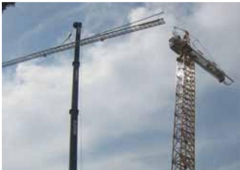
Resulta importante comprobar que la estructura y el entorno de la grúa estén protegidos de posibles colisiones con otras máquinas al realizar el montaje.
