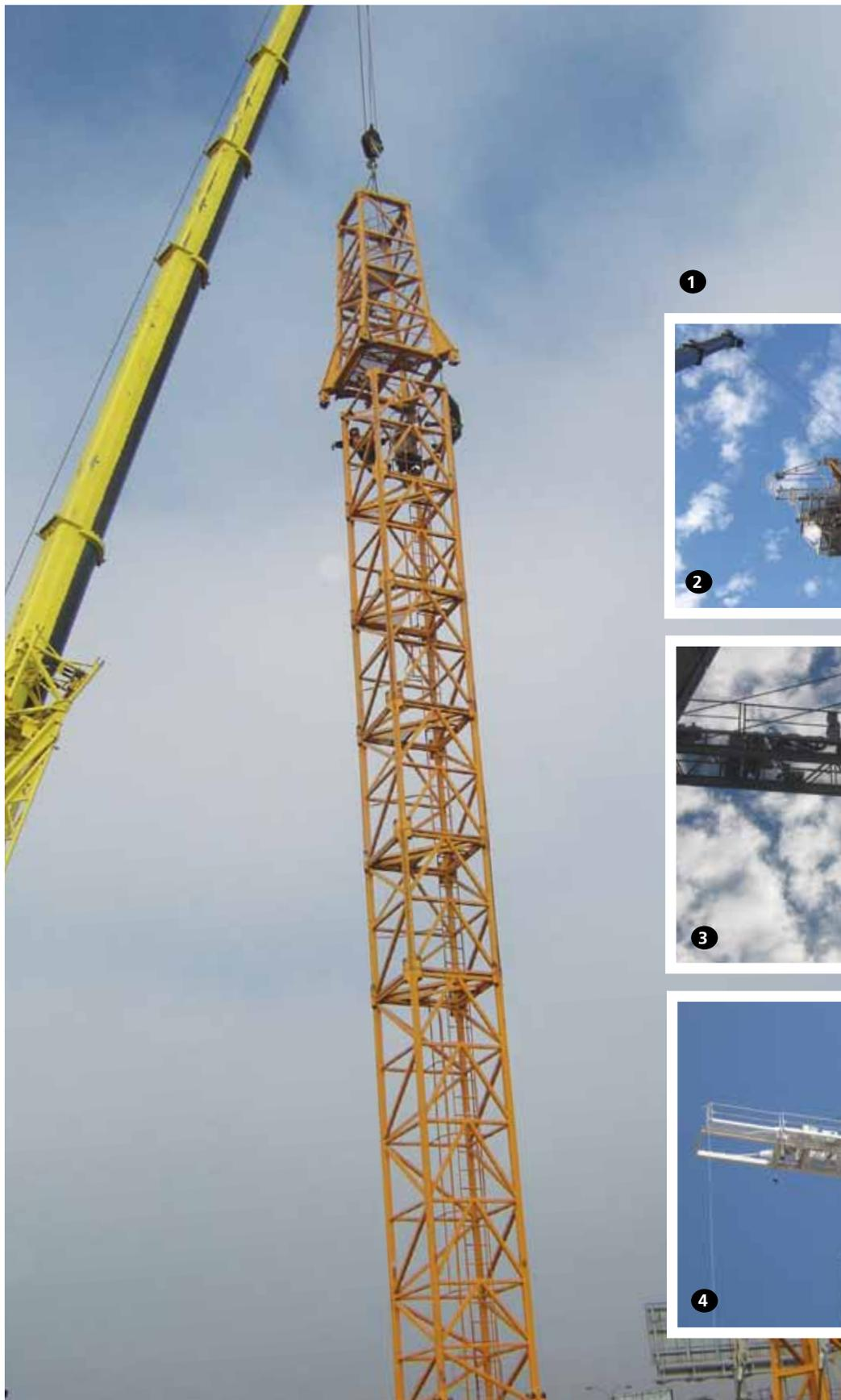
Al instalarse la torre inferior, se procede con el montaje del resto de la torre con los tramos requeridos y el acoplamiento del conjunto superior, punta de torre y mecanismos, entre otros. Fotos 1 a 4.
