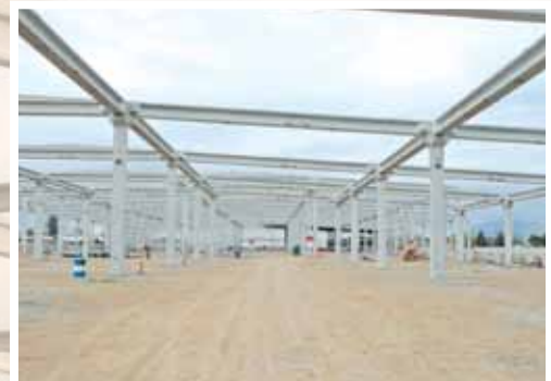
BODEGA FORTALEZA 31.900 m 2 EN RENCA
