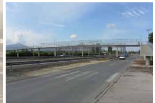
4 PASARELAS EN AUTOPISTA LOS LIBERTADORES
