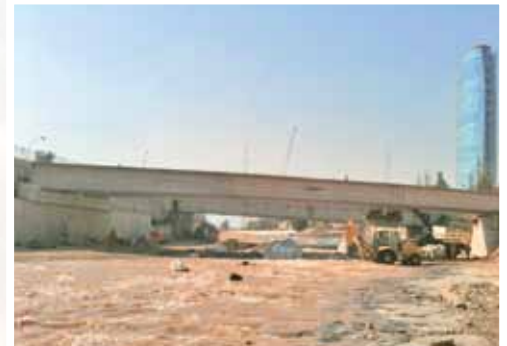
VIGAS PUENTE COSTANERA CENTER
