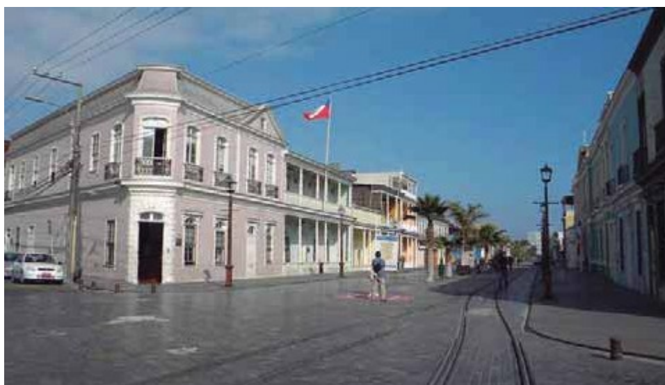
Fachada de la casa iquiqueña, patrimonio cultural de la ciudad portuaria.
