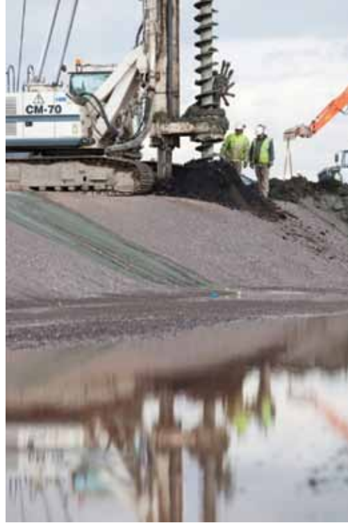
La estructura se montó sobre el antiguo circuito de Eastway. Para dar soporte al recinto, se instalaron 900 pilotes a 26 metros de profundidad.
