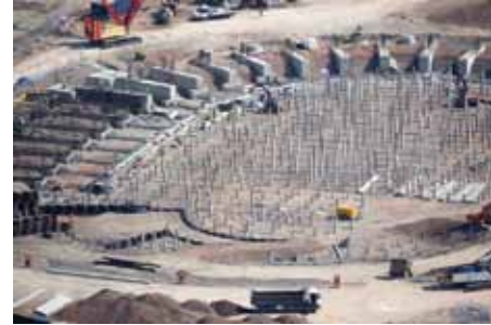
La estructura se montó sobre el antiguo circuito de Eastway. Para dar soporte al recinto, se instalaron 900 pilotes a 26 metros de profundidad.
