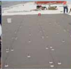
Instalación de Placas ISO 95+ de Firestone
