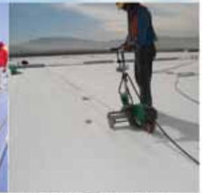
Instalación de membrana TPO de Firestone en techo
