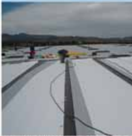
Instalación de Placas ISO 95+ y membrana TPO de Firestone
