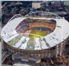
Revestimiento con membrana TPO Firestone
