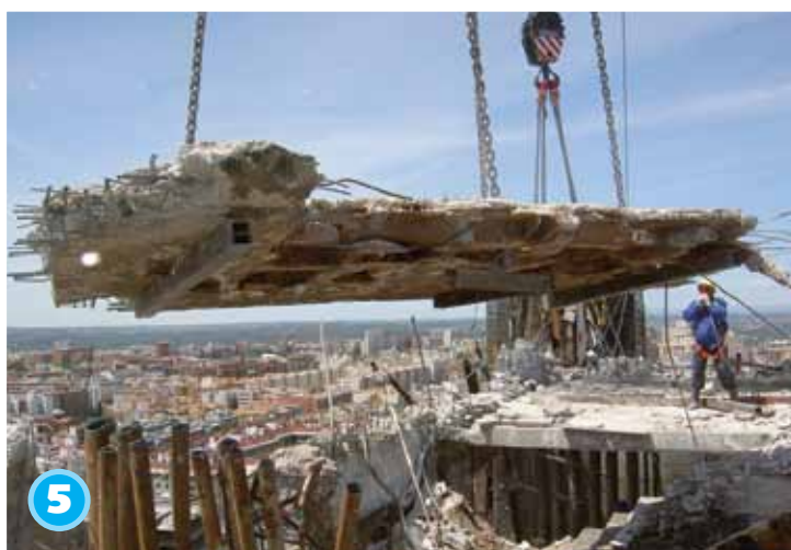
Las grúas retiraron el material que las máquinas fueron sacando.
