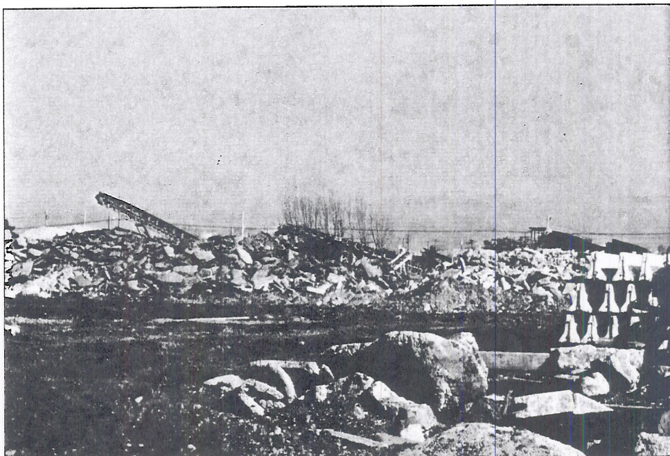
Una planta de reciclaje de residuos de C&D en la Ciudad de Richmond, California, EUA, procesa el hormigón y otros desechos producidos durante la construcción de una autopista mayor.
