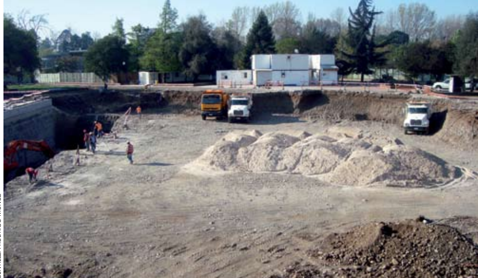
La construcción de una explanada a una cota de -2,5 m respecto del resto de la plaza requirió una excavación de aproximadamente 10 mil m 3 de tierra.
