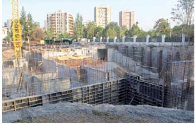
**Izquierda:** Los contrafuertes intercalados con las pilas de socalzado tienen la función de entregarle mayor fuerza a los muros que sostienen la losa principal. **Arriba:** En total son 6 los niveles que se construyeron para el Centro Cultural. 90% de la estructura está bajo tierra.
