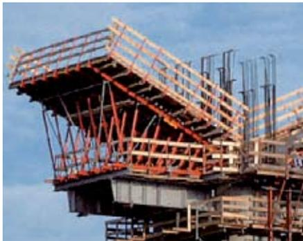
ral para ejecutar muros contra terreno, pilares, vigas de losa, alzaprimados. Aborda casi todas las estructuras de cualquier obra, siendo un sistema que se arma en base a vigas y uniones”, señala Gabriel Toro, gerente técnico de Ulma Chile. La característica de estas vigas es que configuran pilares macizos, por ejemplo, resisten hasta 10 mil kilos de carga. “Es un sistema mecano versátil que se aplicó con buenos resultados en Brasil y Perú”, indica Toro.
