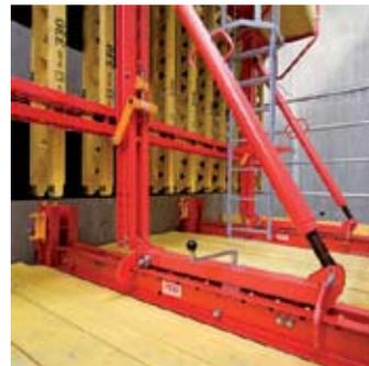
**Arriba.** El encofrado se encuentra montado firmemente sobre el carro de desplazamiento y puede retirarse sin grúa hasta 90 cm. Izquierda. Las unidades y equipos móviles de autotrepado permiten, en caso de necesidad, trepar sin grúa.
