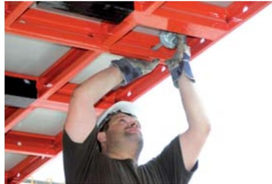
El encofrado para losas Topmax, si bien aún no llega a Chile, es aplicable en losas de estacionamientos, en sistemas postensados, y en todas aquellas superficies planas.
