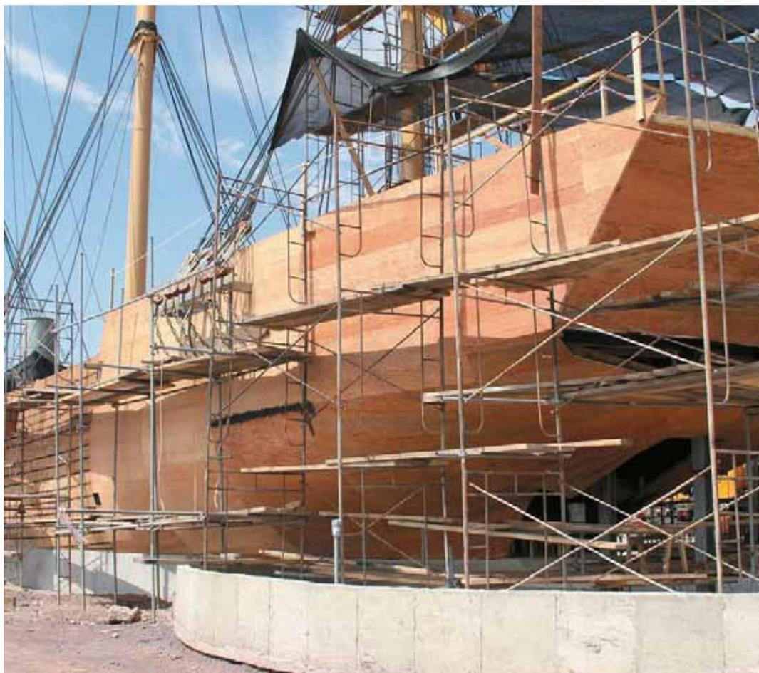
*Una plancha de cobre cubre la superficie de cemento, mientras que con madera de coihue y acero cubierto se reemplazó la teca, madera de la embarcación original, que se tiñó con el fin de darle una apariencia avejentada: al hundirse, en 1879, La Esmeralda ya tenía 23 años.*
